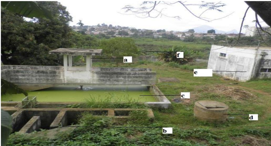
Fig.5. Vue partielle du site d'étude. (a-STEP actuelle; b-Dégrillateur; c-Bassin d'aération ; d-Regard; e-Salle de contrôle; f- Lac Atemengue)
