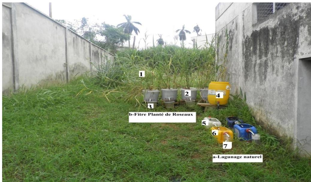
Fig.6. Système hybride (a-lagunage naturel ; b-Filtre planté de roseaux combiné)
